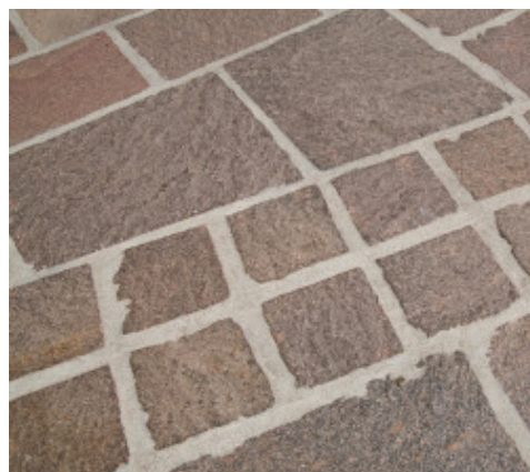
Instalace porfýrových kostek a desek
