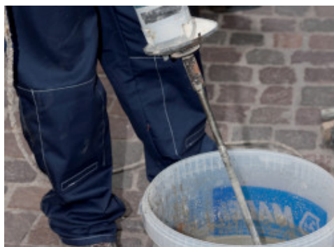
Mapestone PFS PCC 2 smíchejte pouze s vodou s použitím vrtačky s míchacím nástavcem nebo v míchačce na beton
