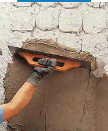
Vyrovňovanie povrchu steny oceľovým hladidlom
