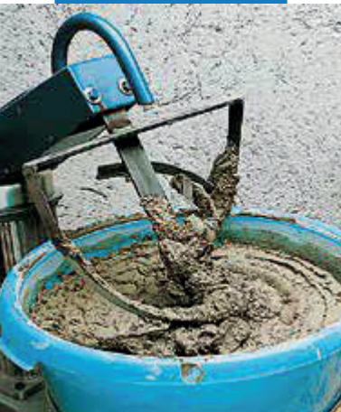
Príprava malty malým miešacím zariadením
