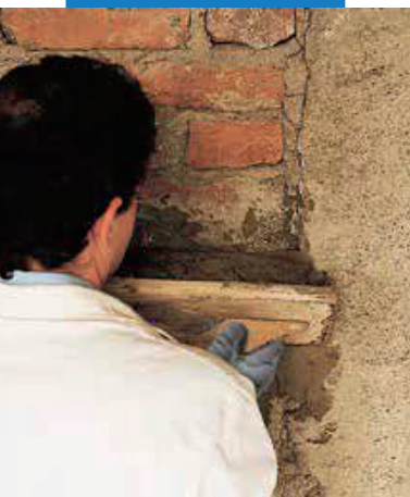
Oprava starého tehlového muriva
