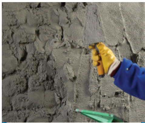
Aplikace Poromapu Deumidificante hladítkem
