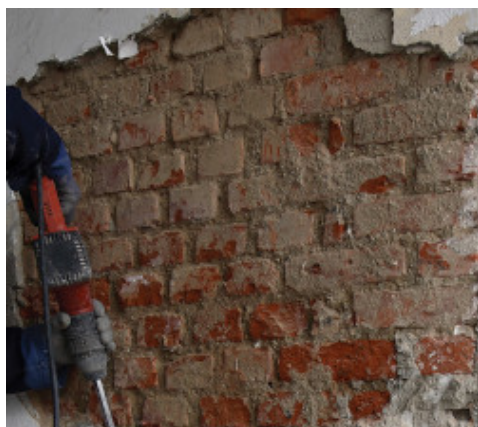
Odstranění stávající omítky
