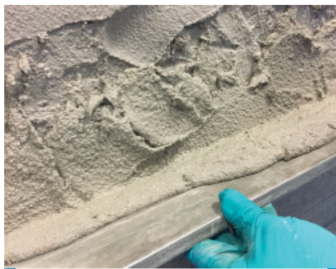
Vyrovňávání povrchu čerstvé omítky PoroMap Deumidificante stahovací latí
