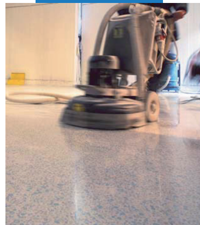
Finálne leštenie podlahy zrealizovanej s Ultratopom a Dynastone Color
