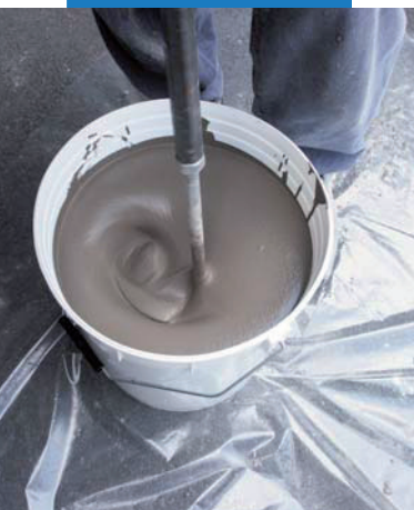
Príprava zmesi ručným miešaním
