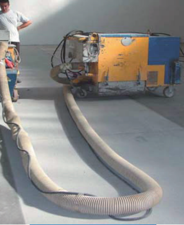
Príprava povrchu otrýskaním
