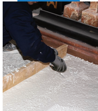
Vyrovnávanie Ultratopu a Dynastone Color ihneď po nanesení
